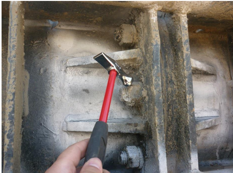
백스테이 및 리더 볼트 체결상태 확인 - 상태 이상 무
